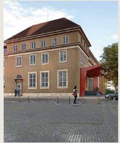
Die WObAU Magdeburg zieht in die alte Staatsbank
