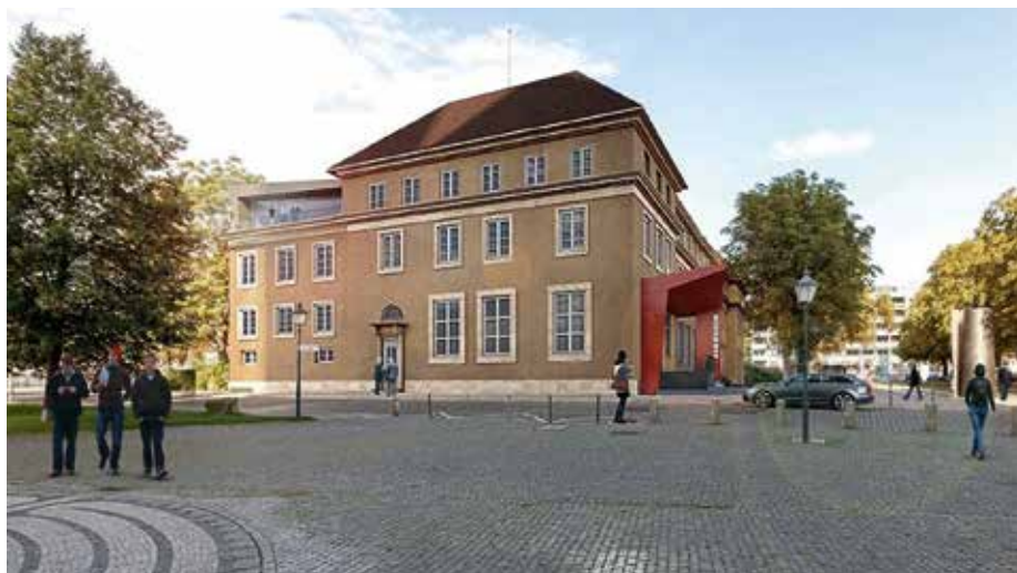
Die alte Staatsbank wird unter anderem zum Sitz der WOBAU umgestaltet.
