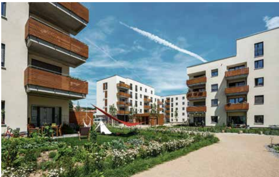
Im Wohnquartier Immergrün entstanden in Jena-Nord sieben Mehrfamilienhäuser mit 90 Wohnungen für junge und ältere Generationen. Quelle: Architekturbüro Wagner / jenawohnen GmbH
