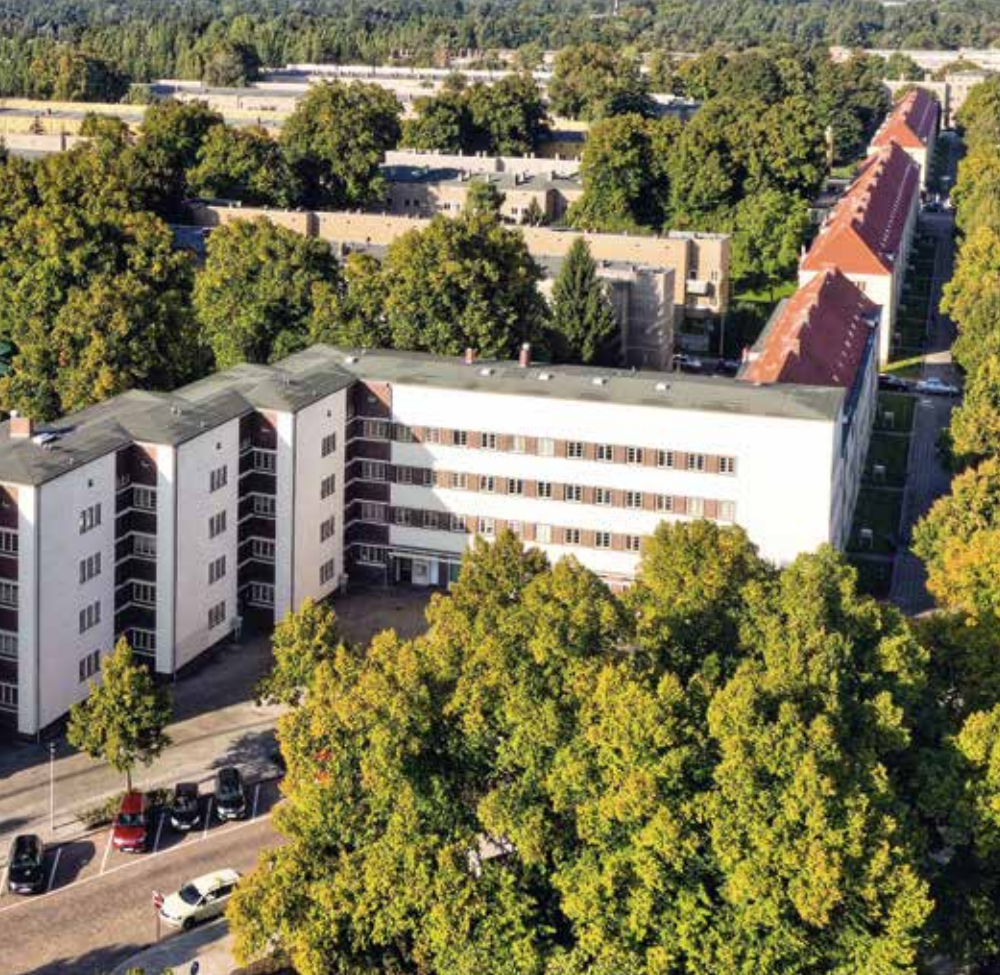
Die Beimssiedlung gehört zu den langfristigen Sanierungsgebieten der WOBAU. Foto: WOBAU
