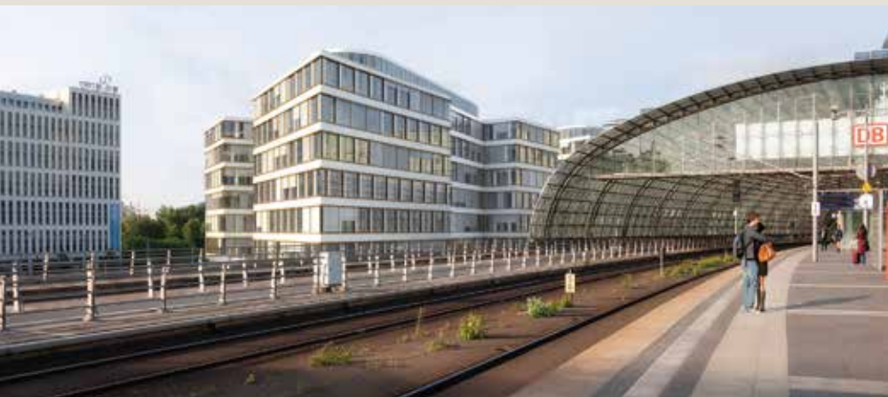
Direkt am Berliner Hauptbahnhof entsteht mit dem Grand Central Berlin bis Ende 2019 Platz für etwa 1.300 Arbeitskräfte in einer hochmodernen Umgebung. Quelle: OVG
