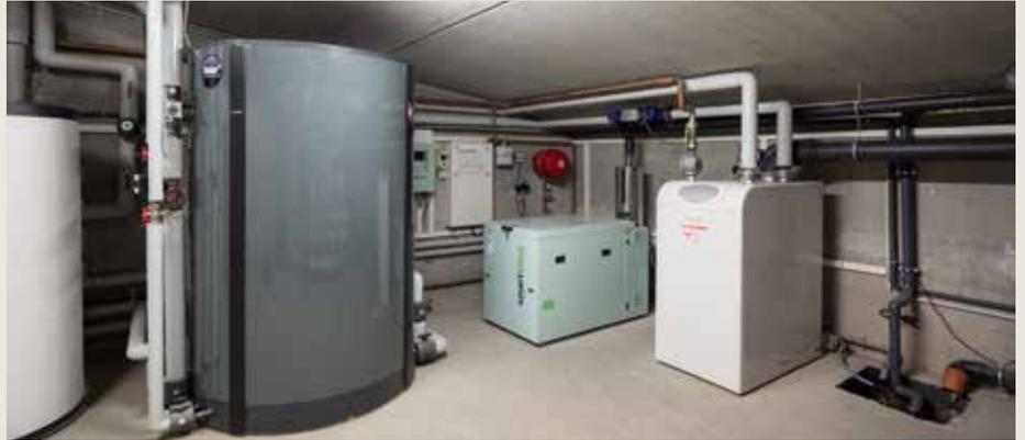
Ein Keller voller Technik: In Hamburg-Ottensen werden ein Blockheizkraftwerk, ein Kessel und mehrere Pufferspeicher (Schicht-Speicher) eingesetzt. Außerdem wird eine Wärmepumpe genutzt (nicht im Bild).
