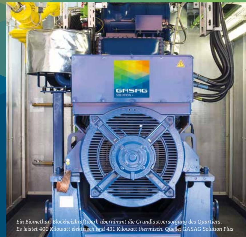
Ein Biomethan-Blockheizkraftwerk übernimmt die Grundlastversorgung des Quartiers. Es leistet 400 Kilowatt elektrisch und 431 Kilowatt thermisch. Quelle: GASAG Solution Plus
