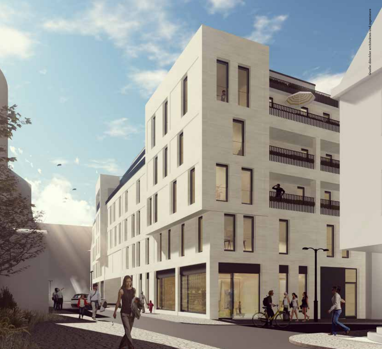
Das Marktcarrée schließt eine Baulücke in Halle.
