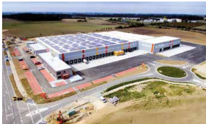
Neubau eines Logistikzentrums nahe Rostock mit ca. 22.000 qm Hallenfläche für den NORMA Lebensmittelfilialbetrieb
