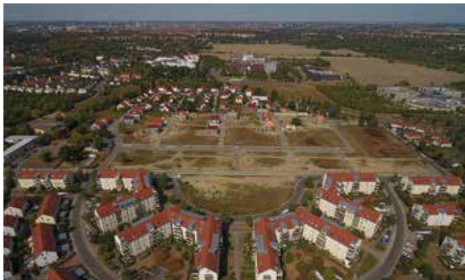
Sonnenpark Leipzig-Probstheida – Baurechtschaffung und Erschließung. Ein Projekt der Unterplan Baubetreuung GmbH.
