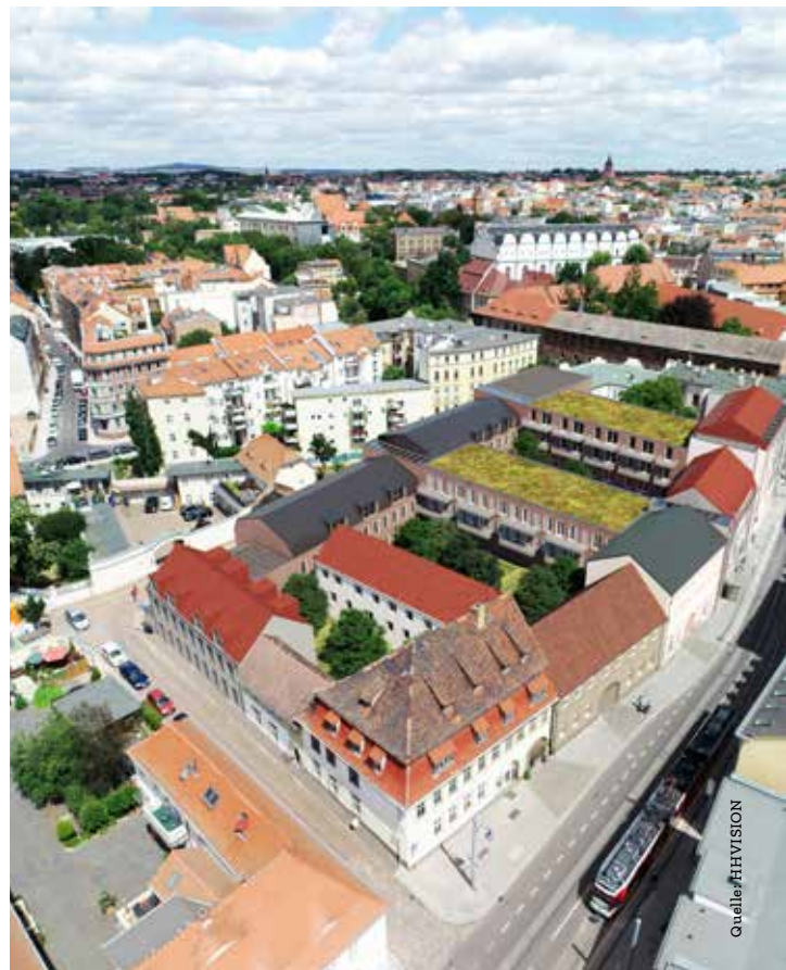
Neue Höfe Tuchrähmen soll bis Ende 2022 fertig gestellt sein.
