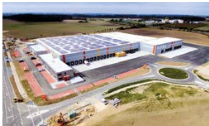
Neubau eines Logistikzentrums nahe Rostock mit ca. 22.000 qm Hallenfläche für den NORMA Lebensmittelbetrieb
