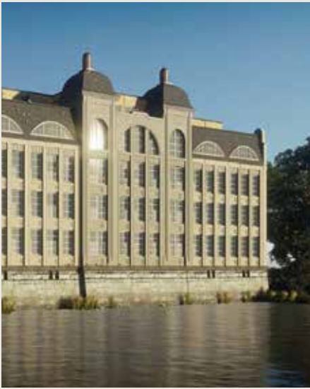
In neuer Schönheit: Die MCM AG saniert in Halle (Saale) eine alte Brauerei.
