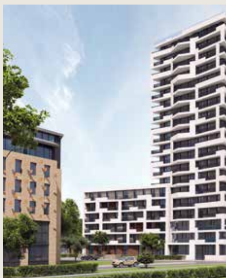
Luisse: Magdeburger Genossenschaft plant Hochhaus
