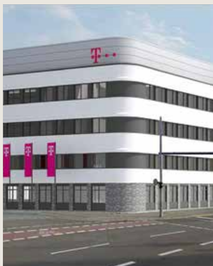
Quadratmeter-Giganten: Firmenzentralen im Bau
