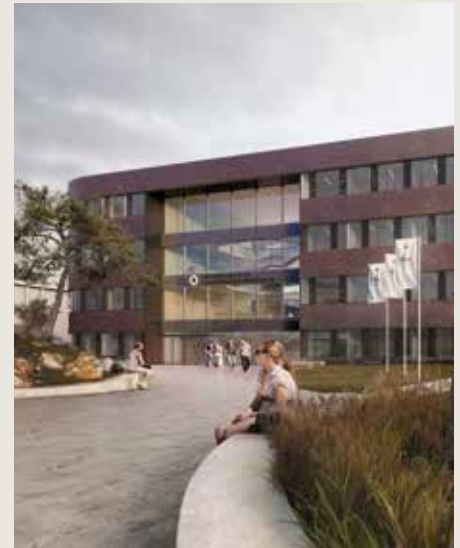
Baustelle Forschung: Wissenschaftler bekommen neue Gebäude
