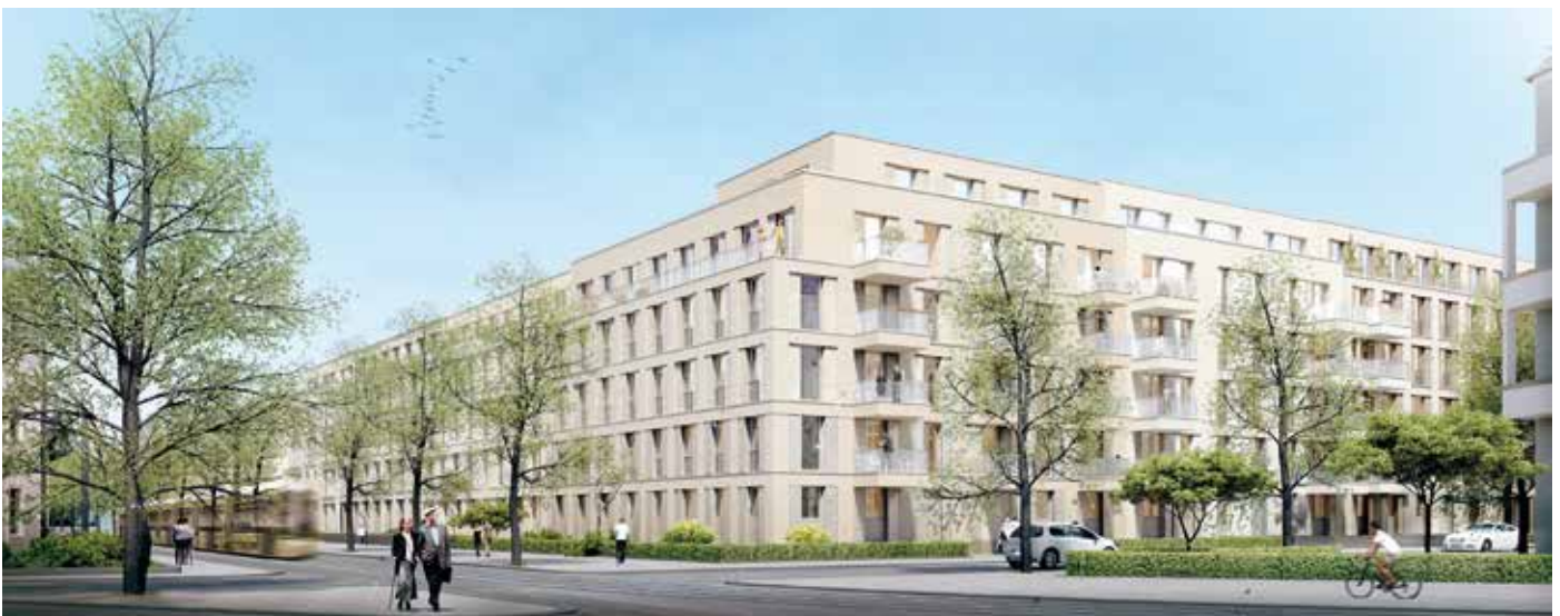
In der Mendelstraße entsteht auf einem 14.000 Quadratmeter großen Grundstück das bisher größte Bauvorhaben der GESOBAU AG. 351 Wohnungen mit einer Wohnfläche von insgesamt 25.000 Quadratmetern werden ab Ende 2018 dem Markt zur Verfügung stehen, 114 als geförderte Wohnungen.
