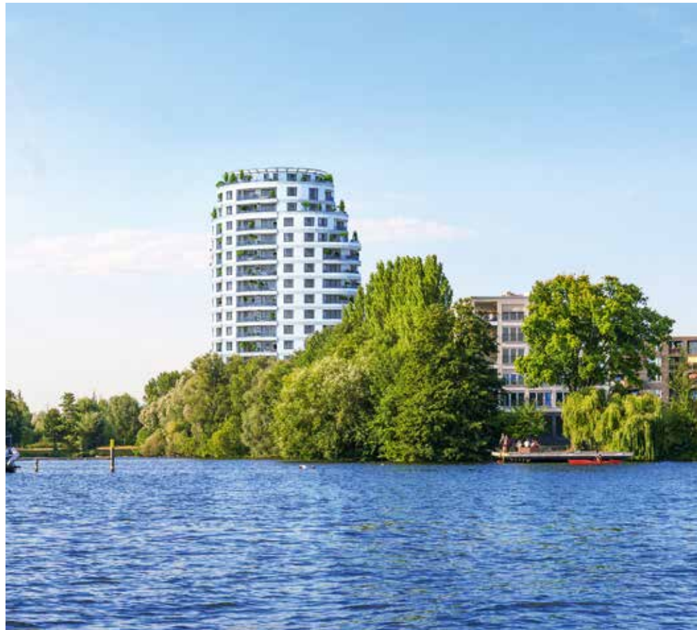
In der Hugo-Cassirer-Straße in Spandau wird ein Wohnneubau realisiert.
